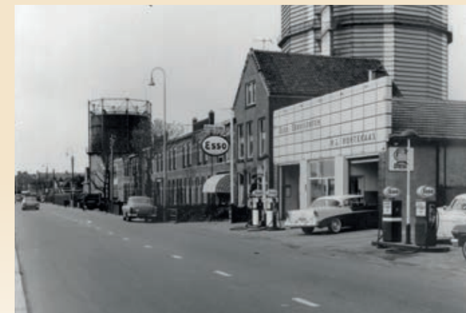
De Nieuweweg. Het huis naast de garage staat er nog.
