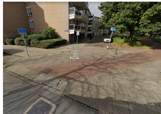
Fietspad op inritconstructie Dirk Buserf
